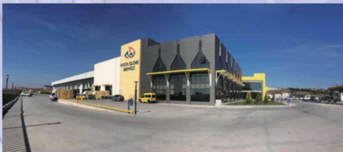
دفتر مرکزی پست استانبول - ترکیه مجموع ظرفیت 2500Kw
